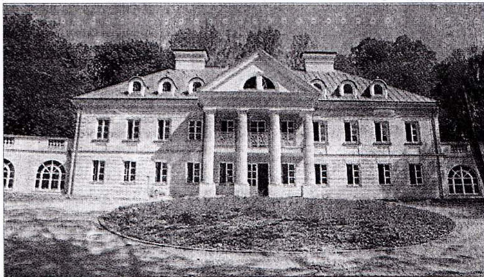
Obecny wygląd pałacu w Śmitowicach
